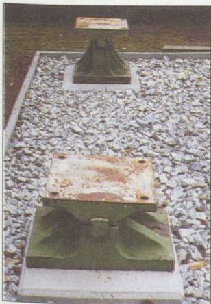
Ihnen kam am 10.11.2001 ebenfalls eine „tragende“ Rolle zu: Eine Nahaufnahme der im Auftrag der Gemeinde vorbereiteten Fundamente. Auf diesen Sockeln wurde wenige Stunden später das Brückenteilstück platziert.
