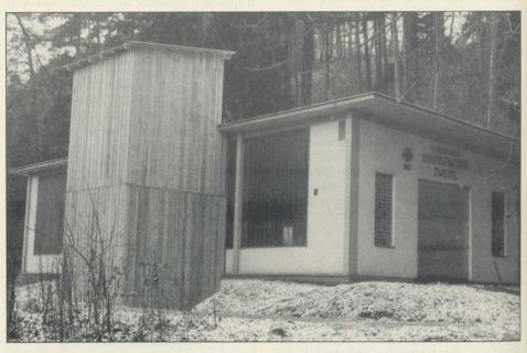
Das Zwettler Wasserwerk mit dem zugebauten Aktivkohlefilter, der zum Schutz vor Kälte mit einer Verschalung versehen wurde
