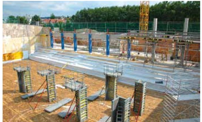
Blick ins Halleninnere: Bodenschutzbelag, Erhöhung der bestehenden Stahlbetonsäulen, im Hintergrund der neue Eingangsbereich mit Garderobe, Buffet und Zugang zur Tribüne, 8. Juni 2015
