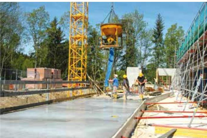
Deckenbetonierarbeiten beim Eingangsbereich (Zubau Süd), 12. Mai 2015
