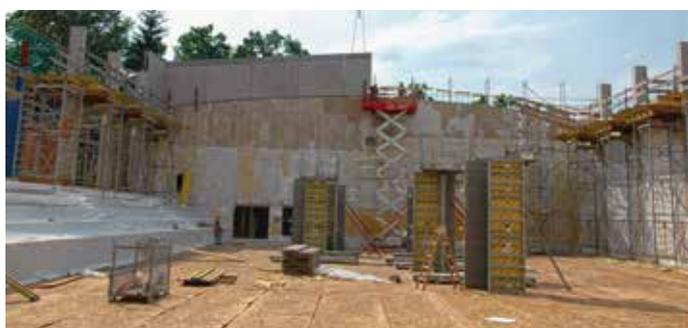
Erhöhung der westlichen Giebelwand (Ausgang Lager- und VIP-Bereich) mit Betonfertigteilelementen, 8. Juni 2015
