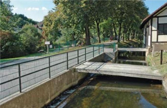
*Schutzmaßnahme auf Anregung besorgter Eltern: Das Geländer beim Durchfluss des Mühlbaches in den Zwettl-Fluss wurde mit einer zusätzlichen Absturzsicherung ausgestattet.*
