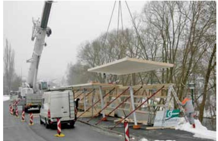
Mit Hilfe eines Spezialkrans wurden die schichtverleimten Holzkonstruktionselemente in Position gebracht und zu einer durchgehenden Holzdecke zusammengefügt. Die gezeigte Aufnahme datiert vom 5. April 2013.
